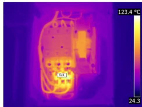
**Abb. 3a+b** Motorschütz mit viel zu hohen Temperaturen am Bauteil und den Anschlüssen trotz besserer Durchlüftung bei geöffnetem Deckel.
