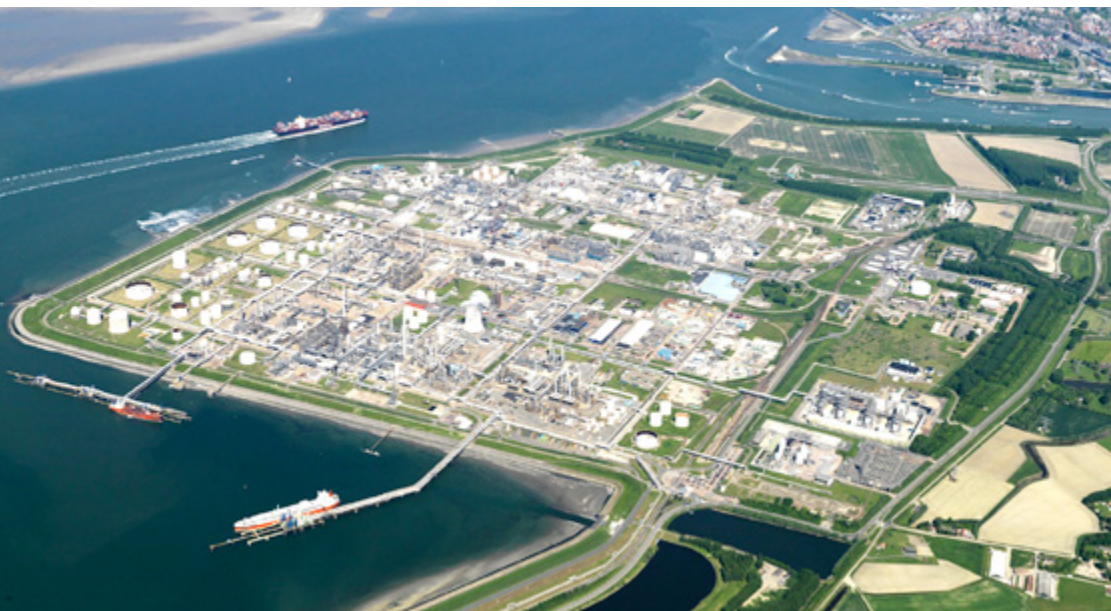
Abb. 2 An der Küste ist die Versorgung mit Frischwasser durch Salzwasserintrusion oft schwierig. Das Bild zeigt den Industriestandort in der Küstenregion in den Niederlanden, der sich in E4Water auf die Aufbereitung alternativer Wasserressourcen konzentriert, sodass sie für den industriellen Gebrauch verwendet werden können.
