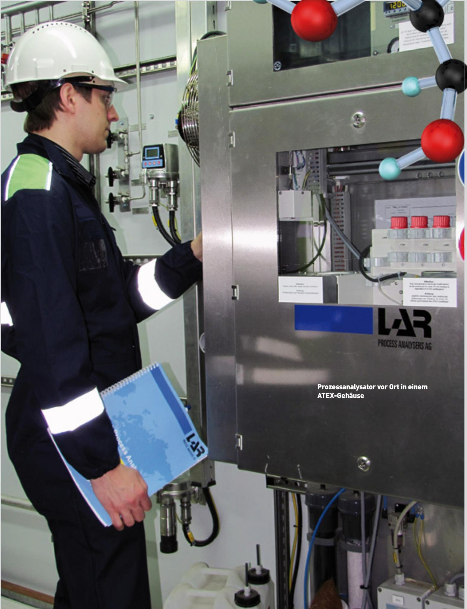
Prozessanalysator vor Ort in einem ATEX-Gehäuse
