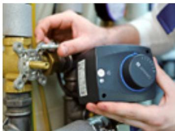
(10Nm statt 6Nm) aufweist. Der lautlose und wartungsfreie Stellmotor ARM hat einen Drehwinkel von 0/90° und eine Umschaltmöglichkeit von Automatik in Handbetrieb, wobei über einen skalierten Drehknopf eine schnelle und präzise Einstellung des Mischventils vorgenommen werden kann.
