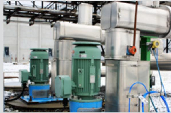
Positive Betriebserfahrung – Pro Abwasserstation sind zwei SG-Pumpen der Firma Egger platziert.
