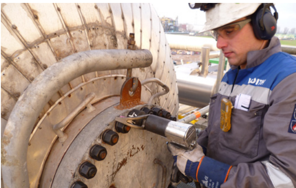
Abb. 1 Verschraubungs- und Verbindungsarbeiten
